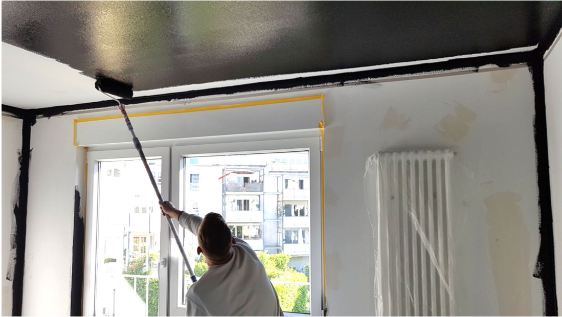
Abb. 09: Raumabschirmung mittels Abschirmfarbe Foto: Christian Blank
